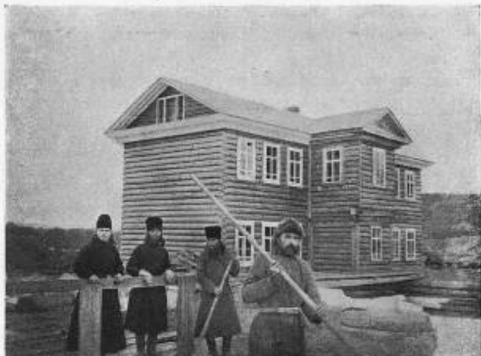
Домъ надъ водопдвижимымъ колесомъ, приводящимъ въ движеніе динамо-машину, лѣсопилку и винторѣзно-строгачъ, ток. станокъ.
