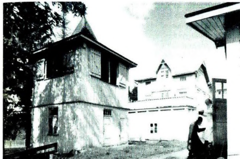
Колокольня, главный корпус и церковь Валаамского монастыря в Папинниеме
