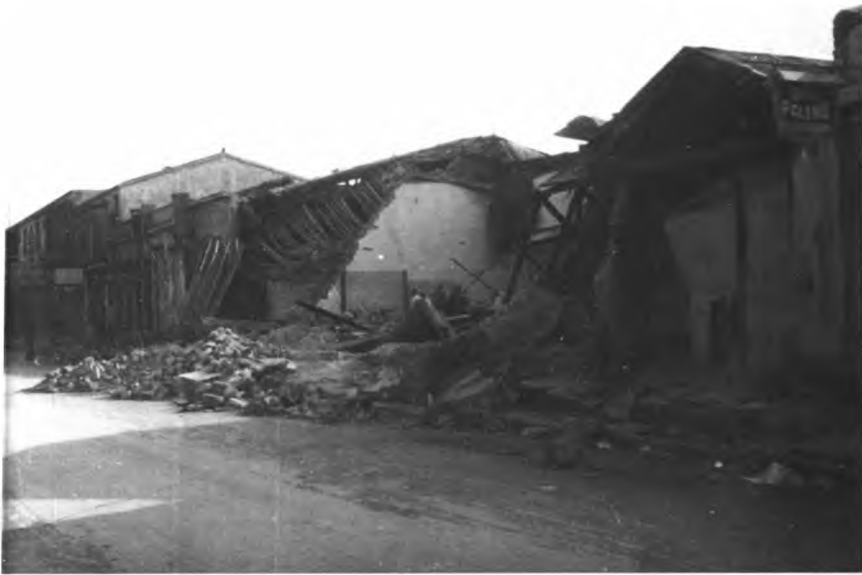
Св.-Николаевская домовая церковь въ Концепсионѣ, разрушенная землетрясеніемъ въ 1960 г.
