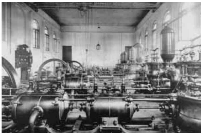
Мытищинский водопровод. Машинный зал. Фото 1900 г. Из собрания В.И. Маслова
