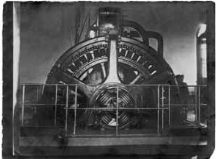
«Мытищи. Динамо-машина, доставляющая энергию к насосам Фарко». Фотография, сделанная П.А. Флоренским и Н.А. Семенниковым 25 октября 1902 г. во время экскурсии вместе с профессором Н.Е. Жуковским на Мытищинский водопровод и посланная отцу. Фрагмент оборотной стороны с подписью П.А. Флоренского
