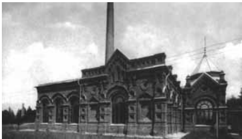
Мытищинский водопровод. Машинный корпус. Фото 1900 г. Из собрания В.И. Маслова
