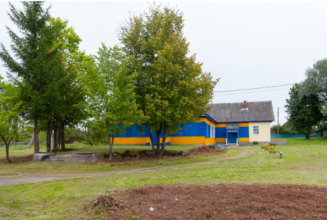
Фундамент Залучской церкви, фото 2017 года
