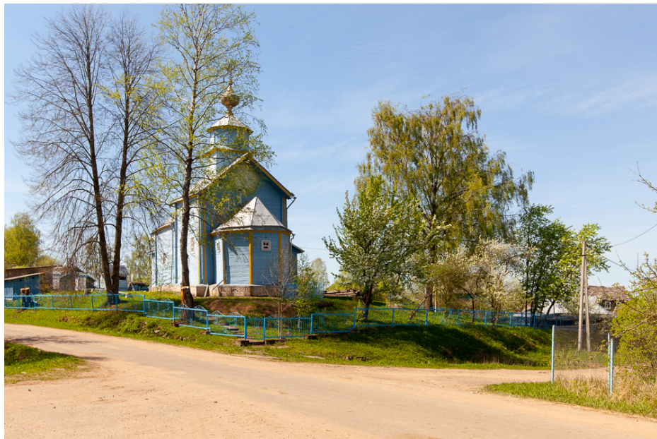
Ильинская церковь, фото 2016 года
