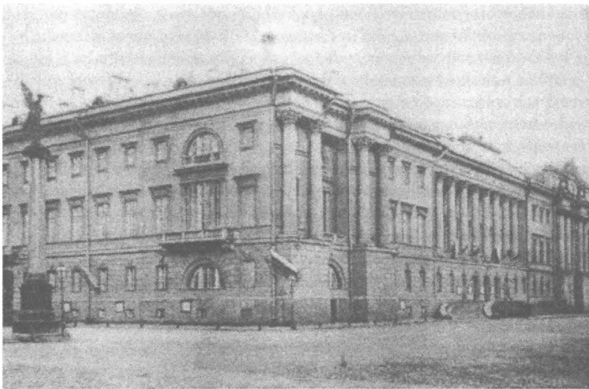
Санкт-Петербург. Здание Св. Синода. Начало XX в.
