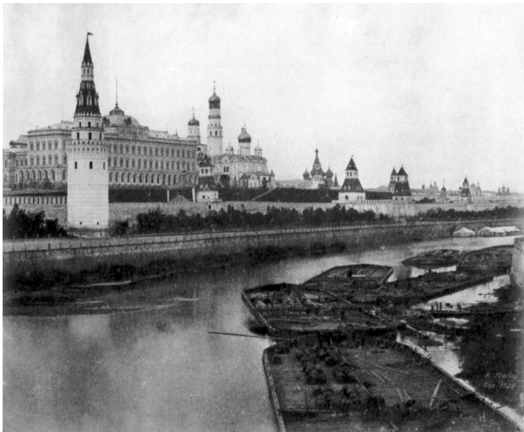
Москва, южная часть Кремля со Старого моста. Фотография 1852 г.
