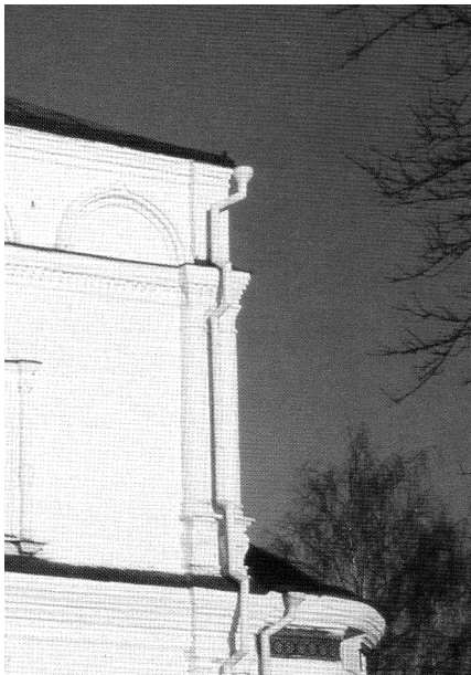
Илл. 10. Фрагмент верхней части южного фасада Преображенского монастырского собора в Рязанском кремле
