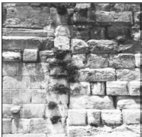
Илл. 1. Прямой стык (шов) Восточной стены.
