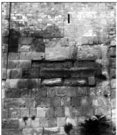
Илл. 2. Руины Двойного Прохода, расположенного между ризалитом башни (слева) и швом (справа).
