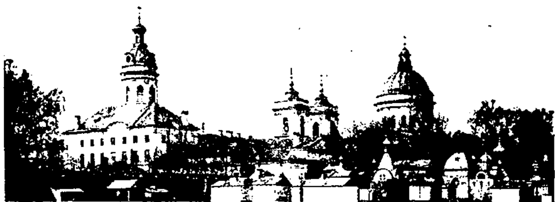
105. Феодоровская и Златоустовская, икиѣ Никольская и Феодоровская, церкви съ Юго-Восточнаго угла.
