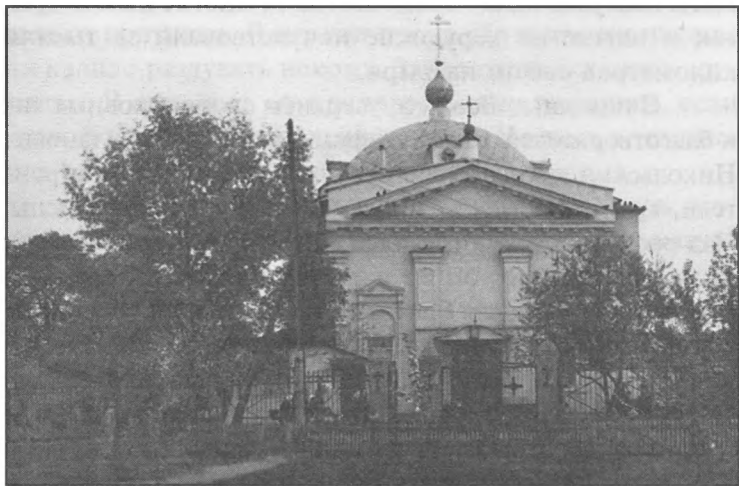
Внешний вид храма после ремонта. Фото автора, 1977 г.
